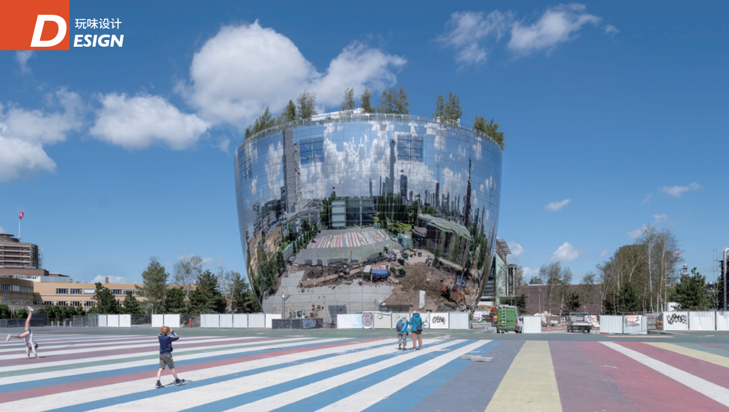
01_高达39.5公尺高的建筑体，由镜面玻璃帷幕，反映出周围的地景地貌。
