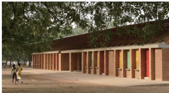
图五：甘多小学运用黏土砖制作，具有通风、隔热效果。 (图源Kéré建筑工作室官网)
