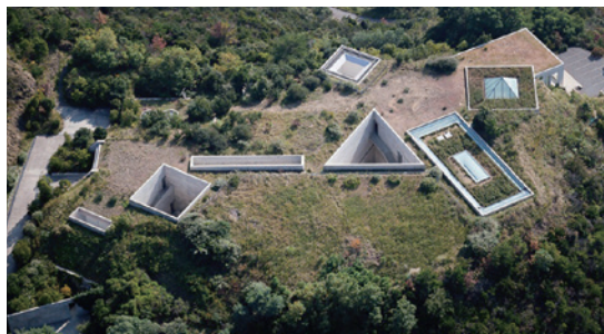
图四：直岛地中美术馆的清水混凝土墙面，透过天窗设置引入自然光之俯瞰图（图源安藤忠雄建筑研究所官网）
