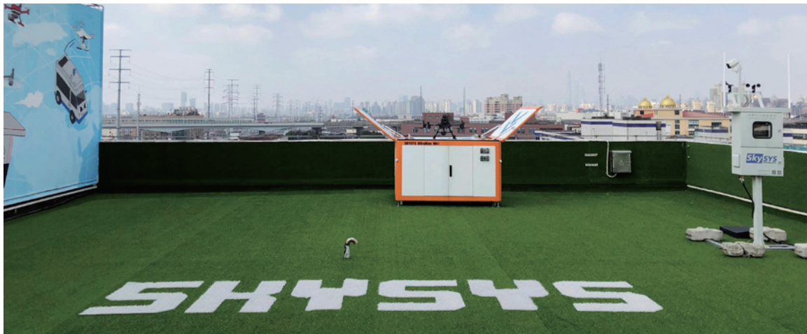
上海麦腾智慧天地无人机站点
