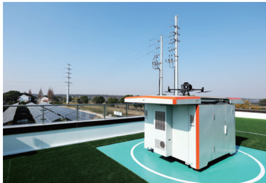
上海崇明“渔光互补”无人机巡检项目
