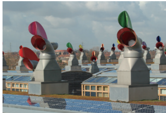
“风帽”可协助室内通风，调节室温；太阳能板收集热能。
