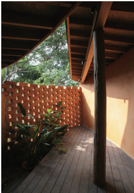
“四口之家”利用废弃的稻秆制成隔热效果佳的预铸墙，让建材取自大自然，也容易回归大自然。
