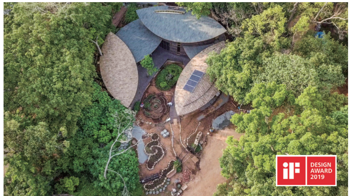
根据推估，荣获2019德国iF设计奖的“四口之家”有超过九成的永续建材可重新回归土地，而相较于同规模的水泥建筑，可减少37.74%碳排放量。
